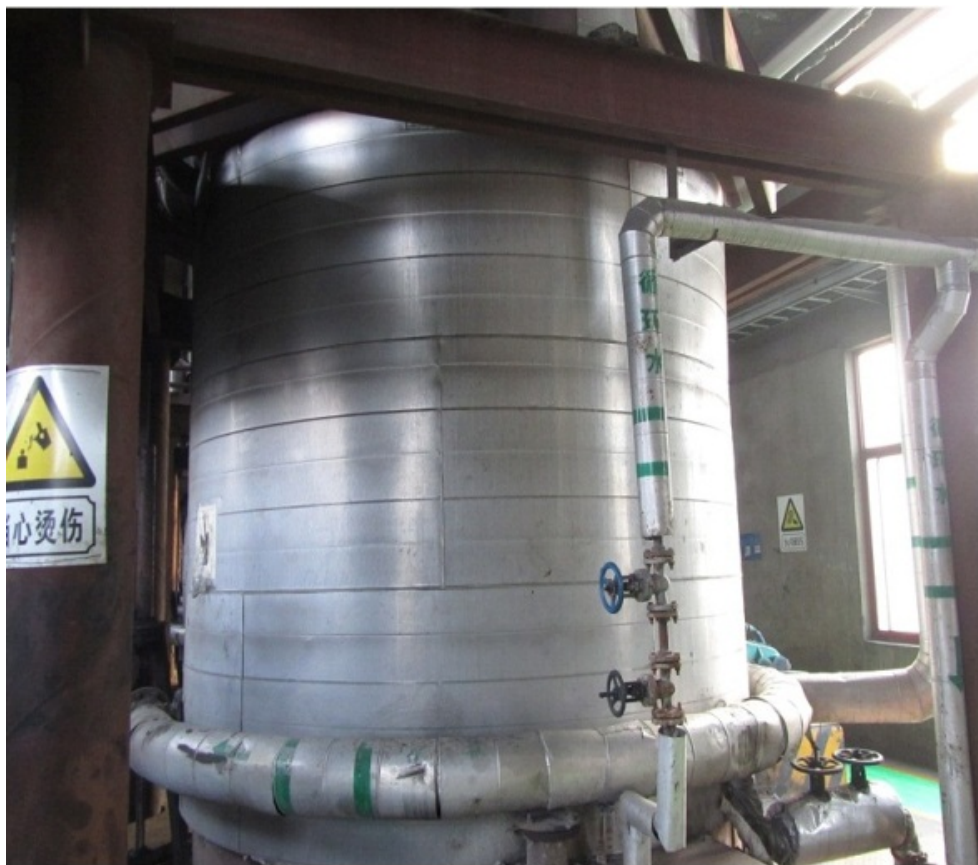
甲烷二氧化碳重整反应器 ( \phi 2.6\text{m} )
